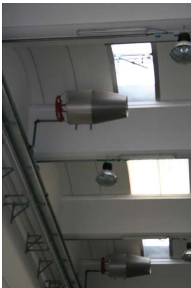
11 – Particolare delle bocchette di erogazione di schiuma antincendio, provenienti dalla centrale antincendio; sono in grado di estinguere un incendio in pochi minuti.
