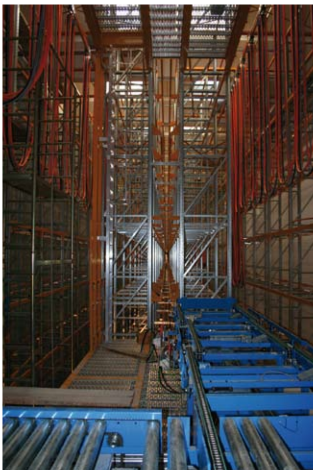
10 – Vista del grande magazzino automatizzato: il locale è completamente attrezzato con scaffalature metalliche, e lo spostamento dei pallets, tramite traslatori orizzontali e verticali, è completamente gestito da un software ad hoc .
