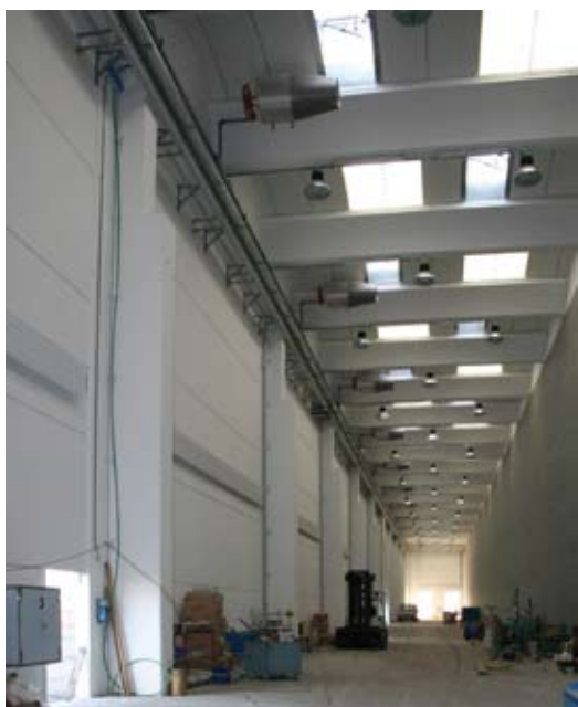
12 – Il “polmone” che separa il magazzino dagli altri reparti. In caso di incendio viene riempito di schiuma per isolare il magazzino.
