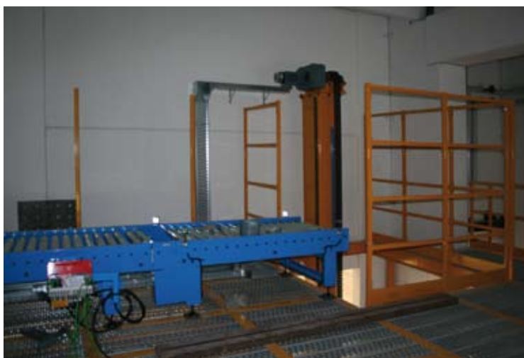
13 – Rulliera orizzontale per la traslazione dei contenitori già pallettizzati e la collocazione, tramite elevatori/discensori, sulle scaffalature del magazzino.
